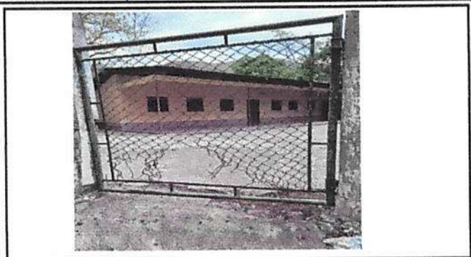
Foto 1: Reparación de portón.
