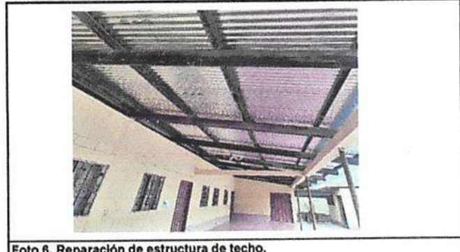
Foto 6: Reparación de estructura de techo.
