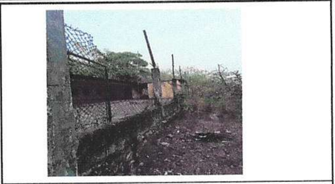
Foto 2: Reparación del muro perimetral.
